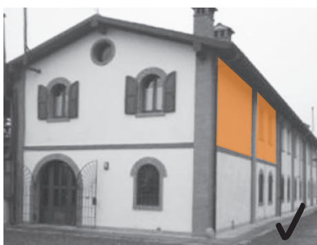
Tamponamento "pieno" su piano terra e piano superiore, con mantenimento delle aperture modulari già presenti in facciata
