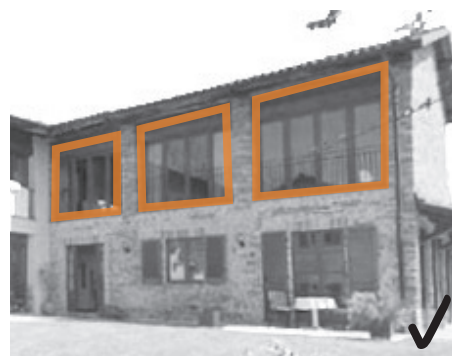
Tamponamento "pieno" su piano terra e parete vetrata al piano superiore
